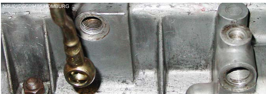
Foto Carterhuis TT Rechts (oliefilterhuis) de aansluiting van de oliekoelslang naar de oliekoeler. Links de aansluiting van het verdeelstuk en de nokkenasleiding.
